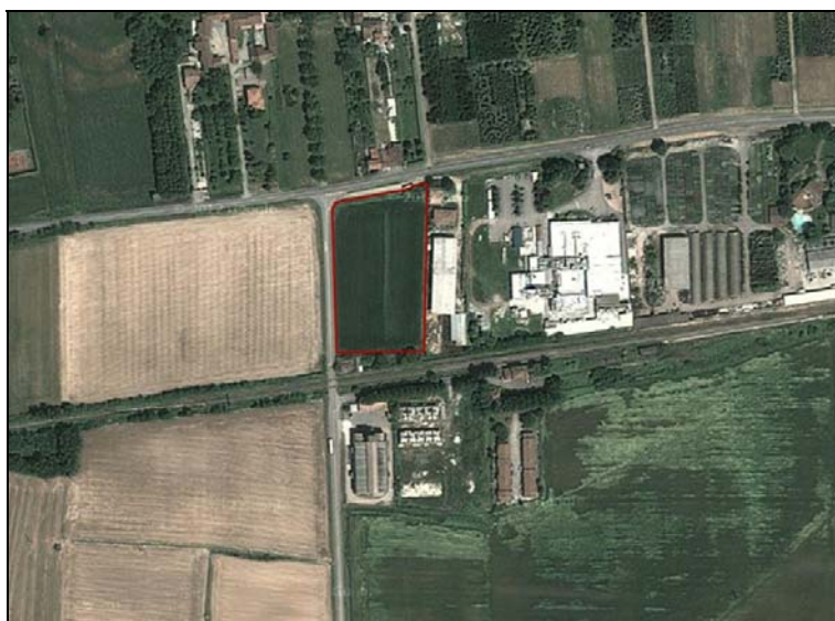
Figura 32. ATP-PCC 1. Foto aerea
